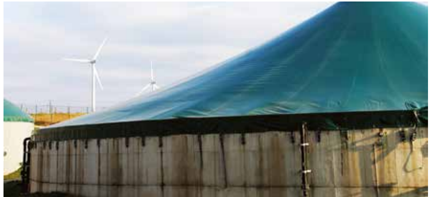
Avec son unité de méthanisation, la SAS Methanergie alimente le réseau de chaleur d'Amenoncourt grâce à la valorisation de la chaleur issue du moteur qui brûle le biogaz faisant tourner la génératrice d'électricité.
